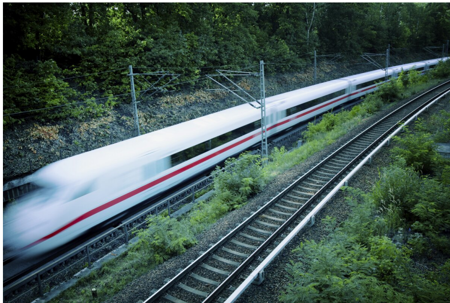
Figura 40. Vías para ferrocarril de alta velocidad en Noruega
