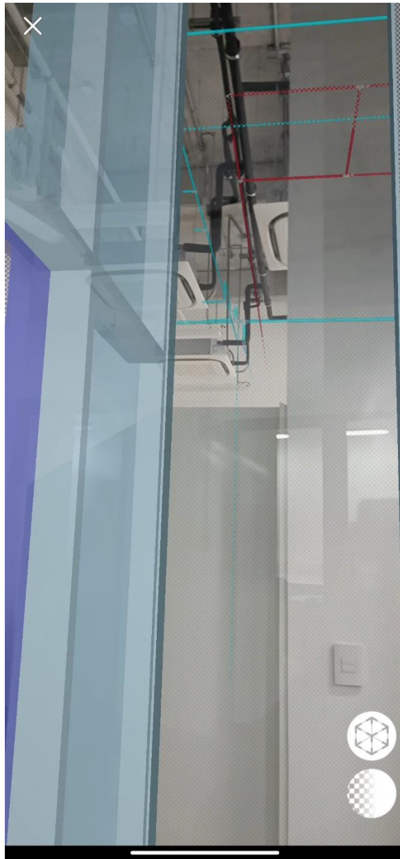
Figura 48. Filtro de color en tubería hidráulica
