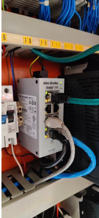
Figura 22: Switchera para red al PLC del área.
