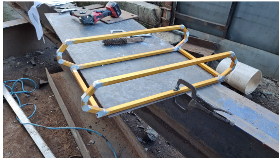
Figura 38: Estructura base soldada durante la fabricación
