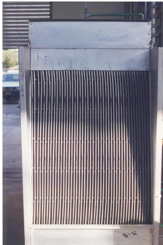
Figura 7. Torre de enfriamiento empaque
