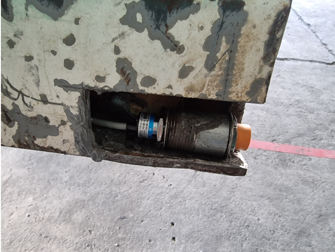
Figura 46: Colocación de sensor
