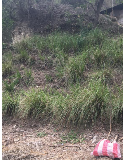
Imagen 13. Tramo de talud utilizando Sistema Vetiver
