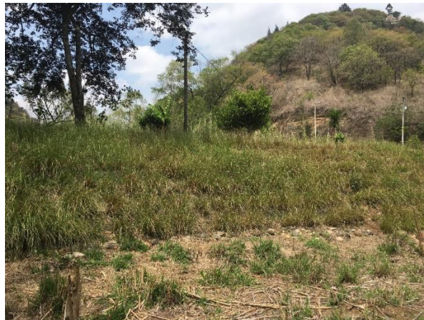
Imagen 14. Tramo de talud utilizando Sistema Vetiver combinado con geomanto
