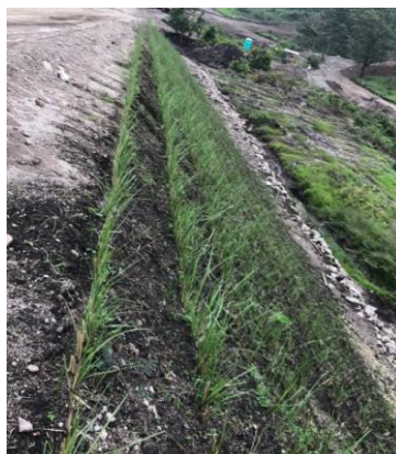
Imagen 4. Sistema Vetiver utilizado en talud
