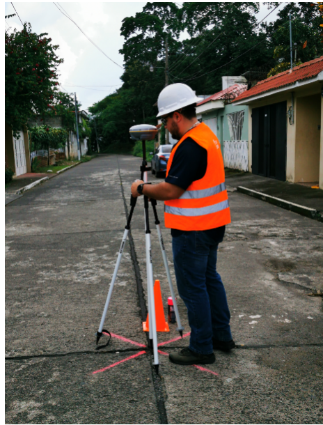
Figura 36: Armado y nivelado de receptores Fuente: Elaboración propia
