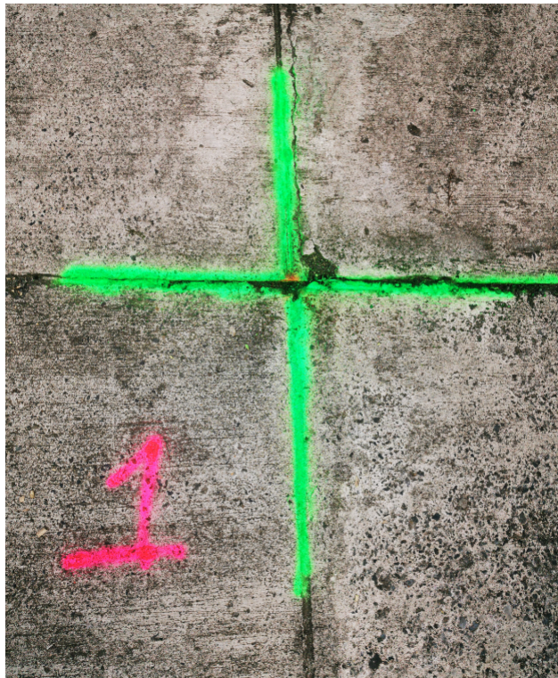
Figura 35: Marca de punto de control Fuente: Elaboración propia
