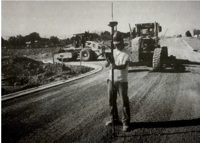
Figura 5: Receptor GNSS aplicado en obra [4]
