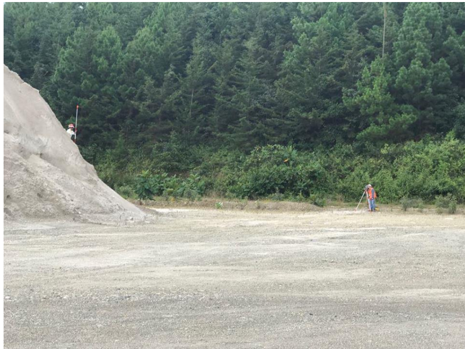
Figura 86. Toma de puntos con la estación total y el prisma.
