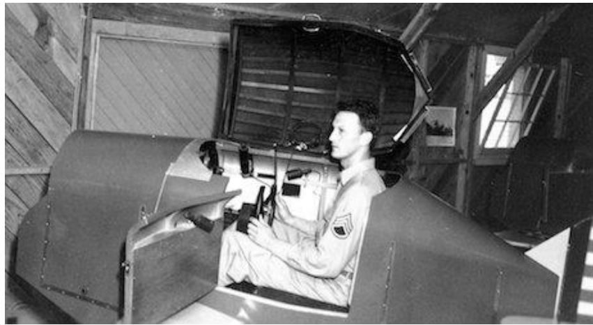
Figura 2 Simulador Link Trainer.
