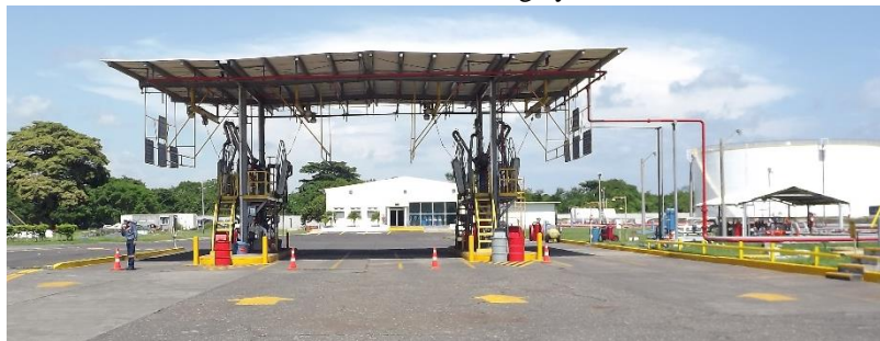
Ilustración 4 Área de carga y bombas
